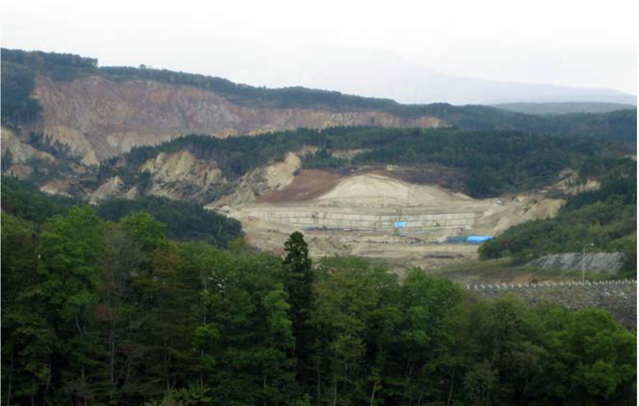
荒砥沢ダム崩落箇所には、重機が入り、貴重な自然遺産が失われた。2009年秋
