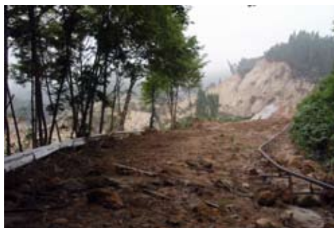
荒砥沢ダム付近の地滑り現場。歩いていくと道路が突然なくなる。アスファルトがないむき出しの状態
